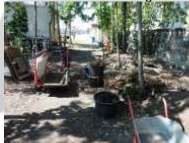
Wurzeln ziehen, Gelände vorbereiten
