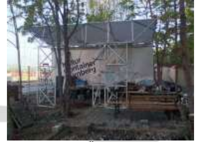
Bau der Überdachung
