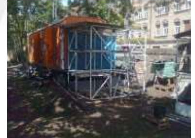
Bau des Materiallagers
